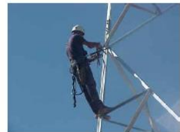
Posicionamiento en apoyo de celosía
